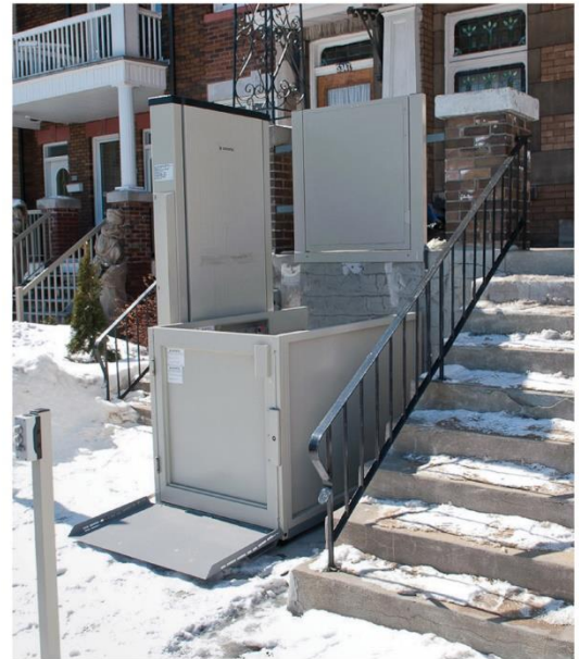
EleveX con porta a bordo e porta nella posizione di fermata superiore
