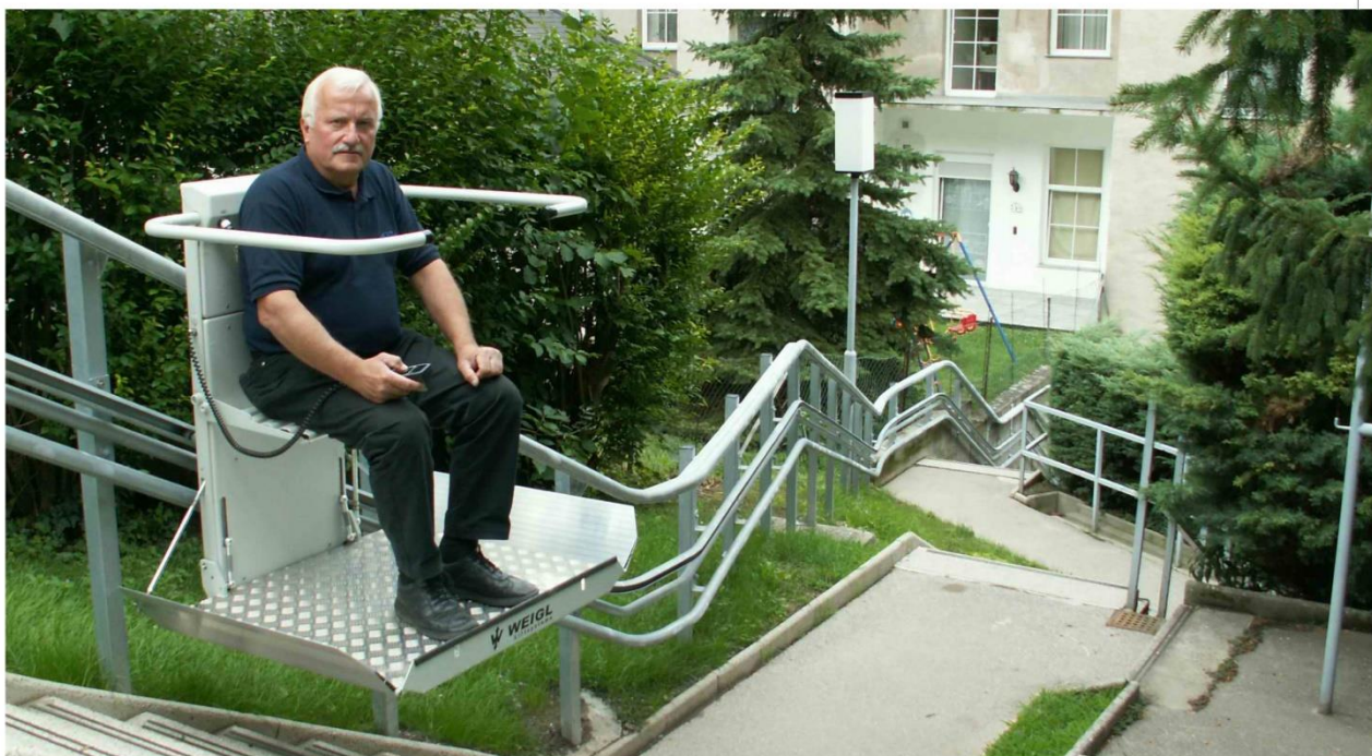
L'azionamento senza batteria consente di effettuare percorsi lunghi anche in impianti esterni
